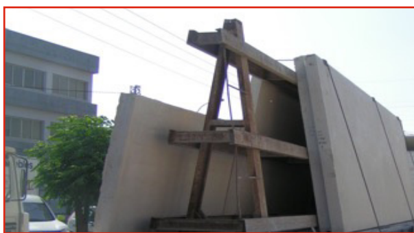
Caballetes de acopio de paneles sobre un camión
