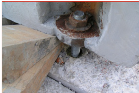
Detalle de unión varilla a cimentación fresca
